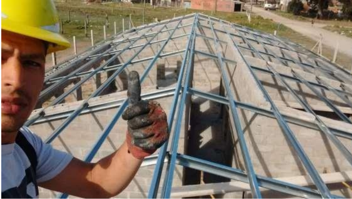
FOTO 8: estructura para cubierta
