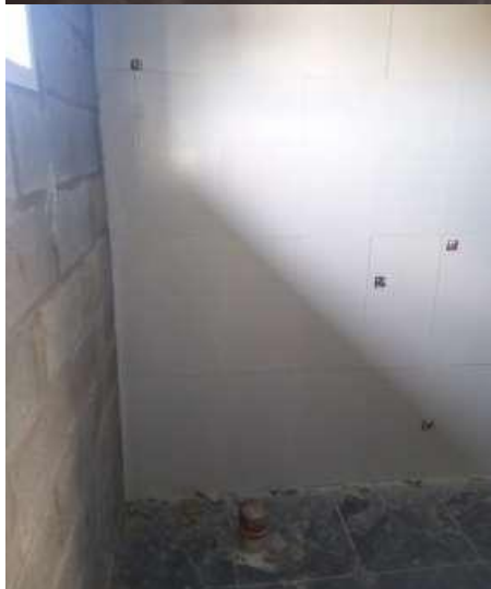
Fotos 23: Terminación en seco interior con revestimiento en baños.
