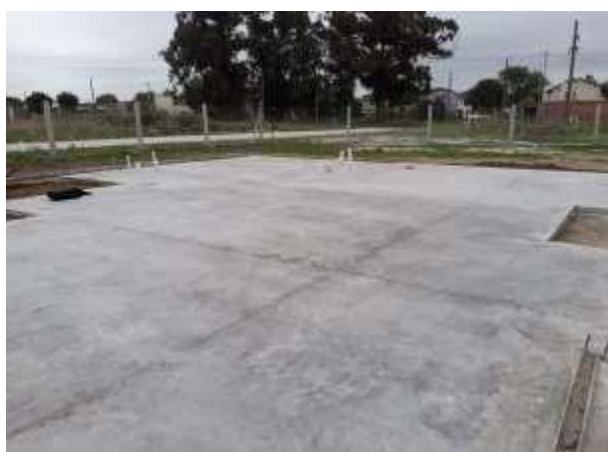
FOTOS 5 A y B: terminación de platea
