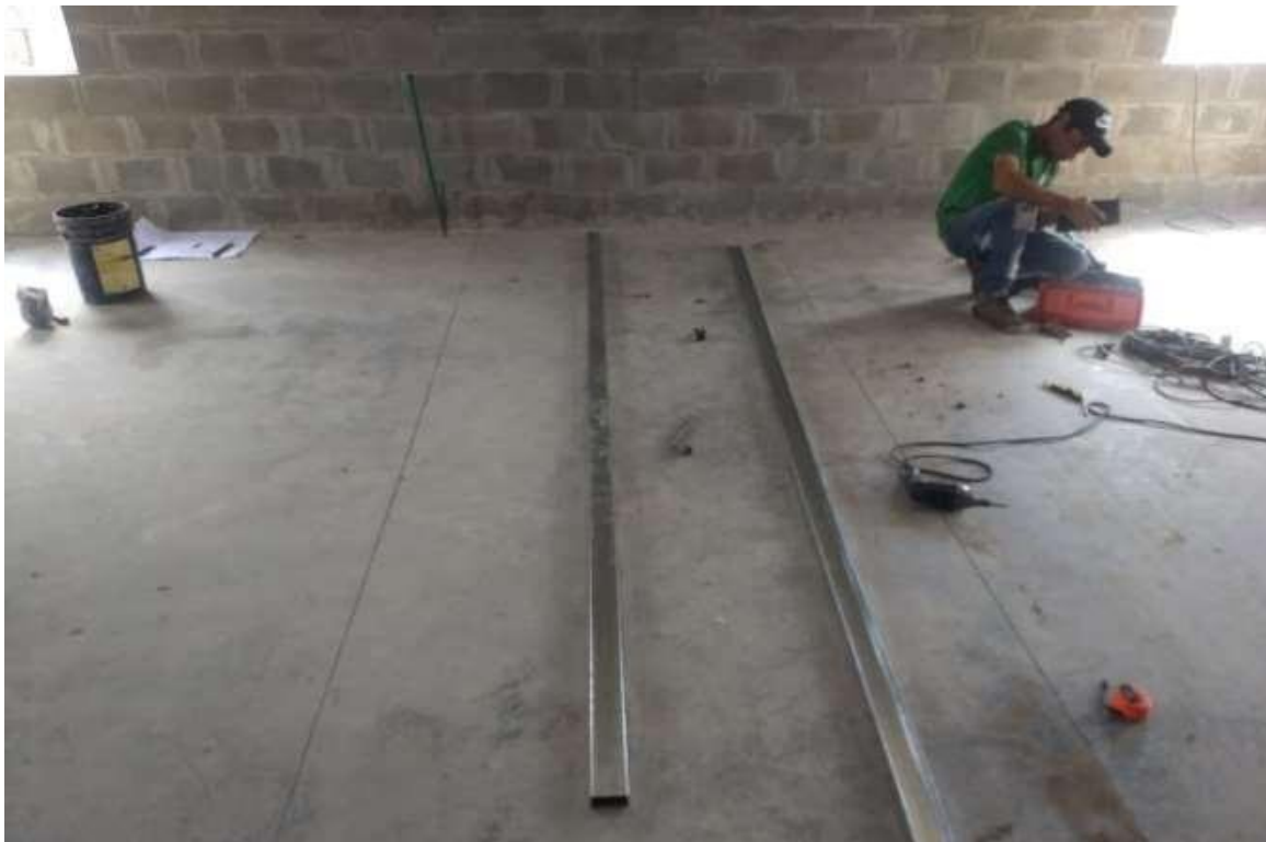
Fotos 11: Damián preparando perfilería de durlock para divisiones internas.
