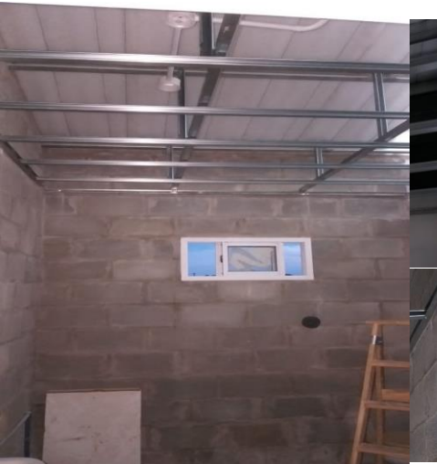
Fotos 40: Estructura de cielorrasos
