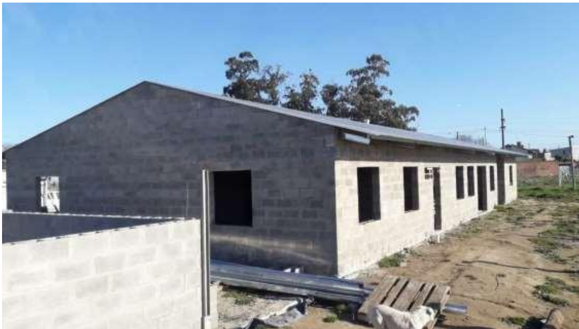
FOTO 9: colocación de chapas en el sector de la Casa de Encuentro
