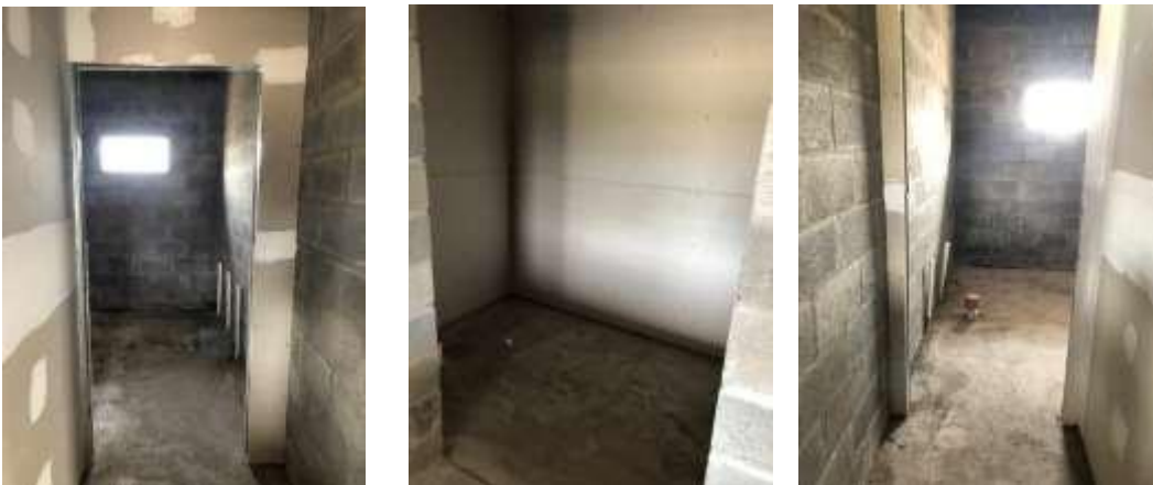
Fotos 13: Tabiques interiores en seco
