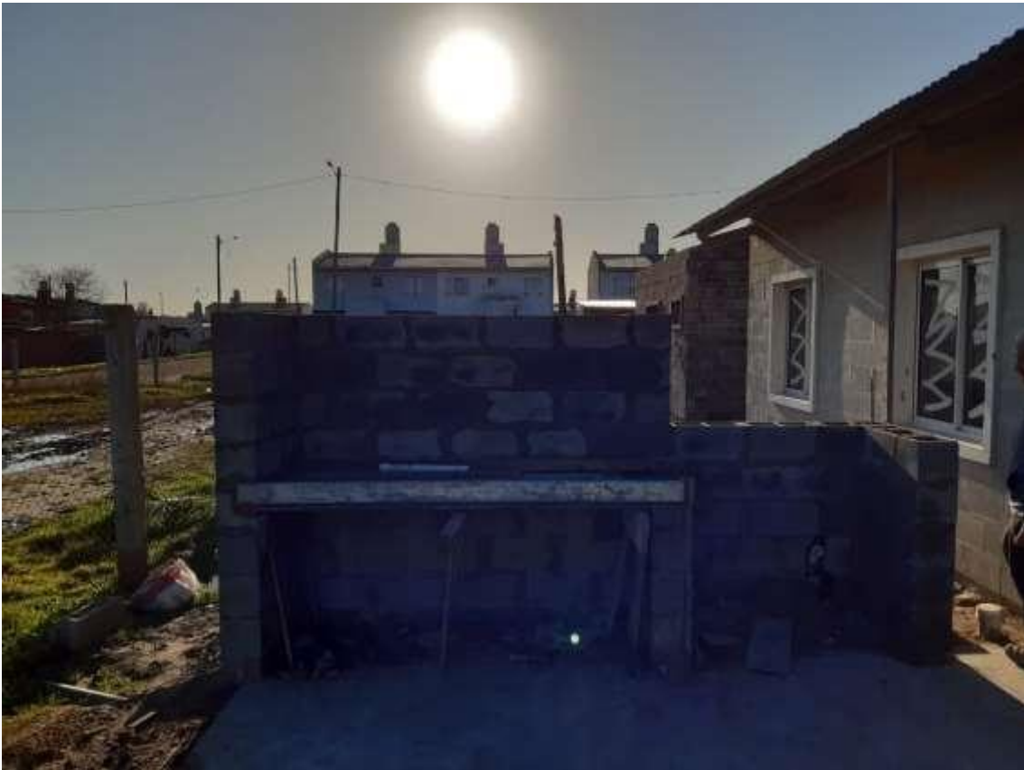
Fotos 26: Avance en parrilla exterior
