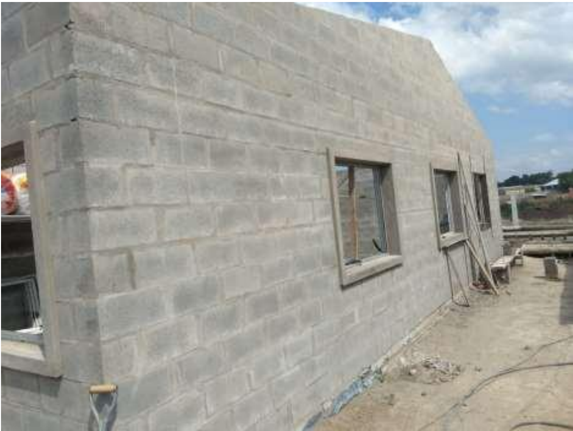
Fotos 10: Ventanas, puertas ventanas y recuadros de albañilería exteriores
