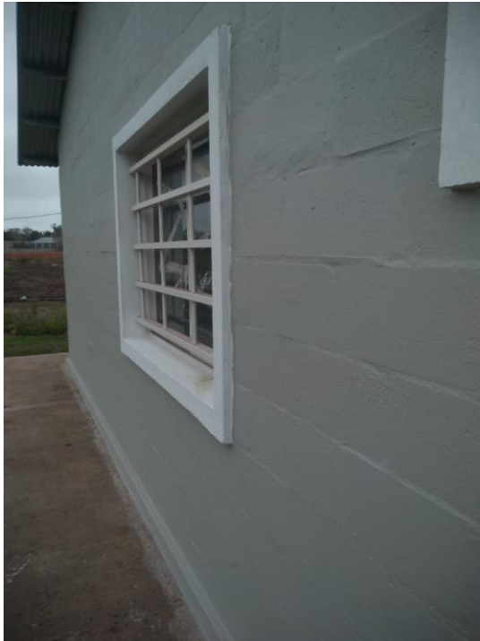
Fotos 56: Impermeabilización externa
