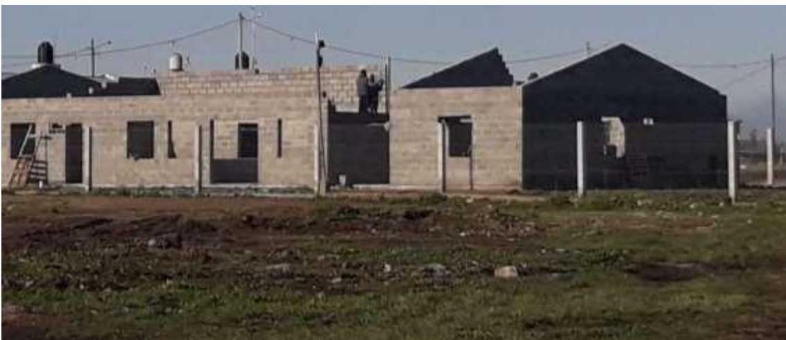
FOTOS 7 A y B: encadenados y enrazado
