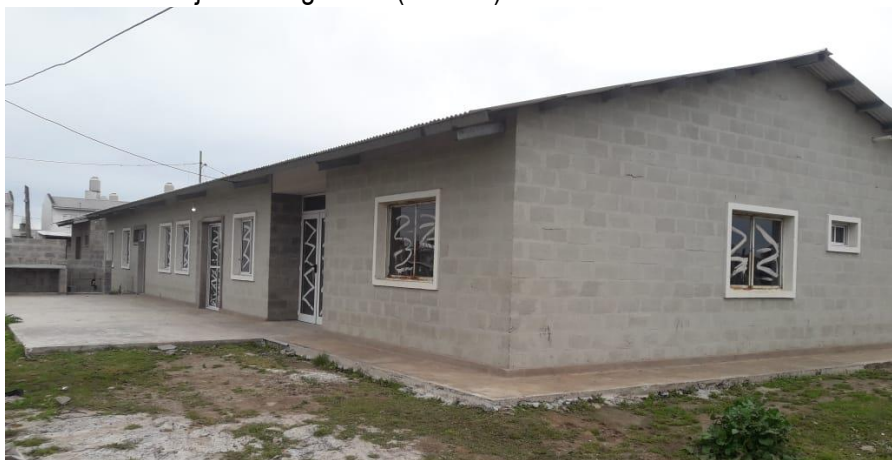
Foto 33: Exterior desde contrafrente
