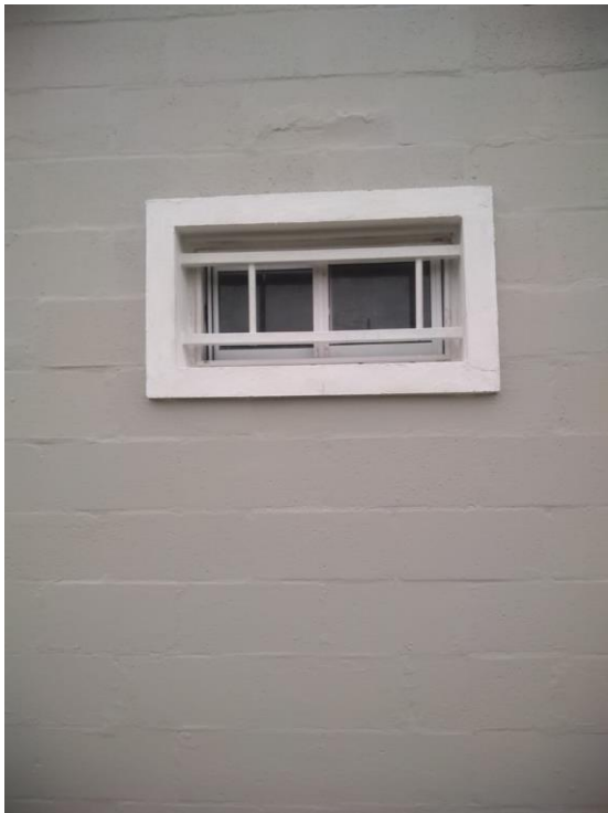
Fotos 57: Impermeabilización Externa
