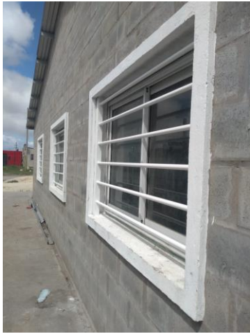
Foto 58: pintura ventanales Taller
