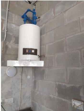
Foto n° 61: termo tanque Cocina
