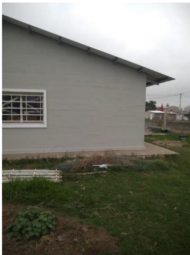
Fotos 55: Impermeabilización externa
