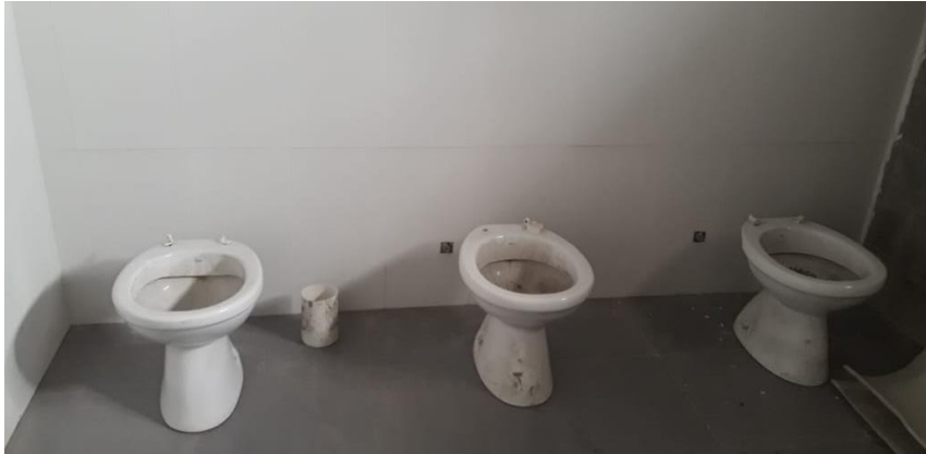
Foto 32: Colocación de sanitarios
