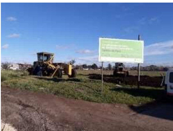
FOTO 1: relleno y compactación
