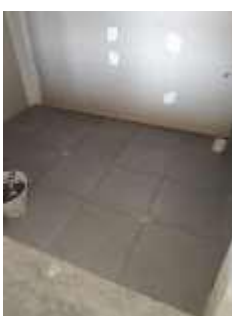
Fotos 17: Colocación de pisos en baños y pasillos.
