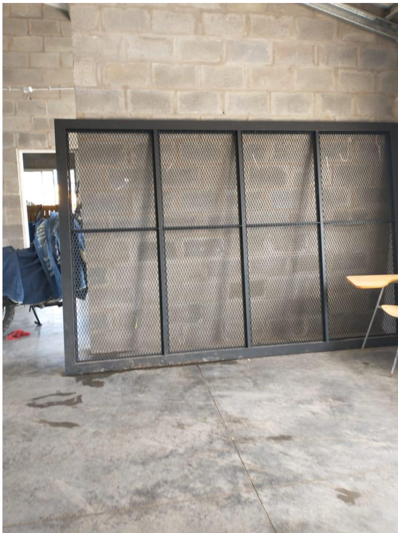
Foto 49: Portón para acceso al predio
