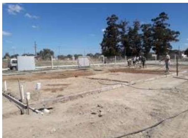
FOTOS 3: replanteo y caños cloacales
