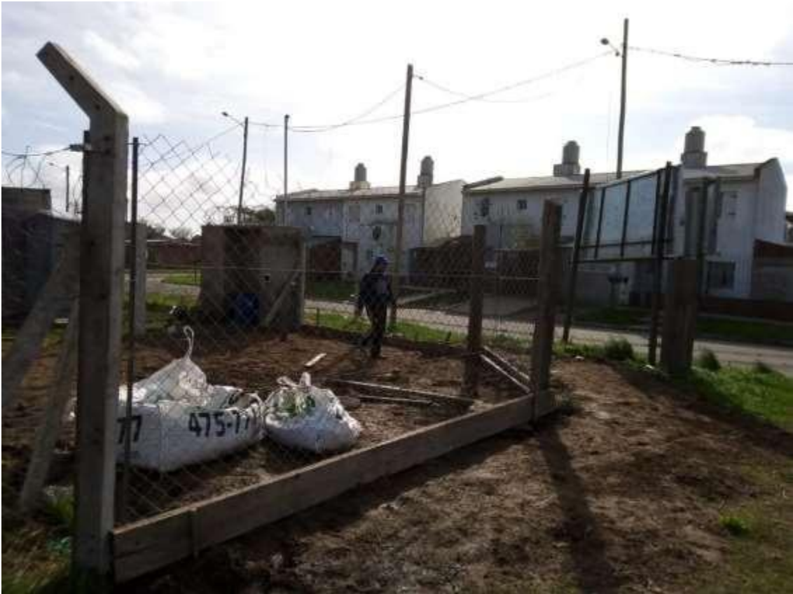
Foto 24: Cerramiento en esquina de Mc Gault y Génova bis por existencia de pozo negro.
