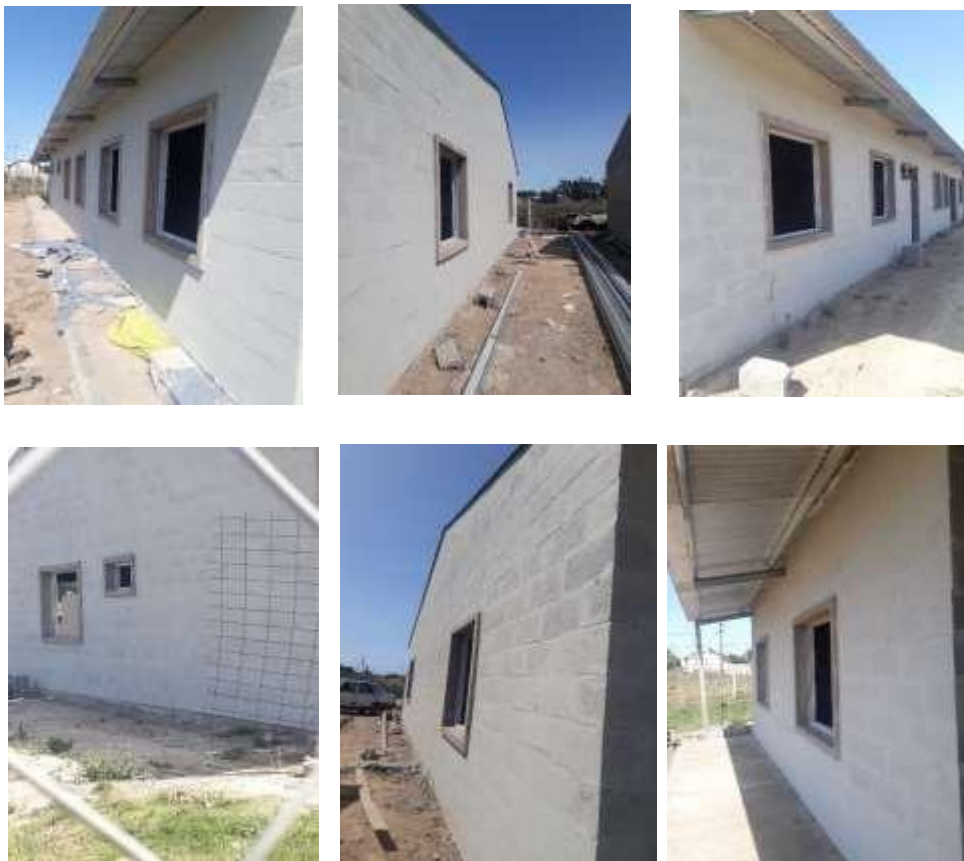
Fotos 18: Pintura de bloques exteriores y recuadros.
