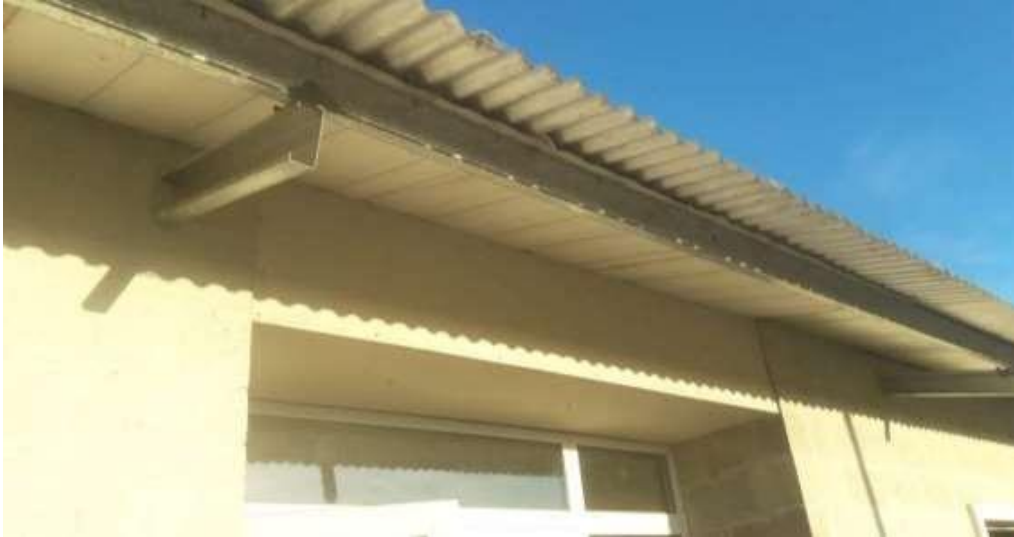
Foto 22: Terminación de encuentro entre cubierta y carpinterías en acceso.
