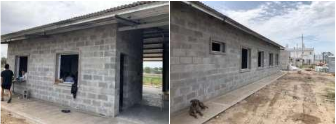
Fotos 12: Veredas perimetrales, y recuadros de albañilería terminadas
