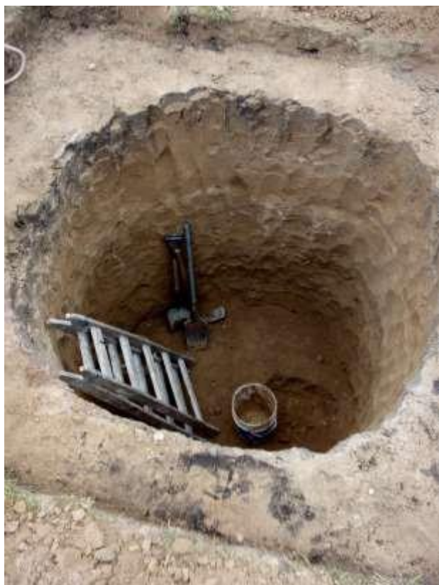
Fotos 20: Excavación de pozo ciego y colocación de tapa de protección.
