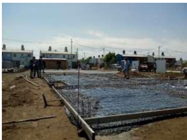
FOTOS 4 A y B: relleno de platea
