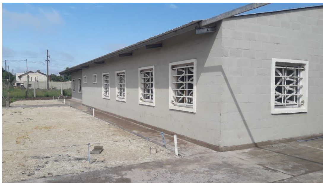
Fotos 35: Colocación y pintura de rejas
