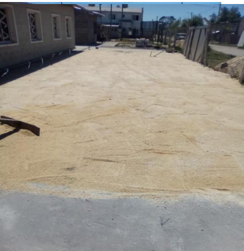
Fotos 34: Completamiento de sector vereda con árido fino
